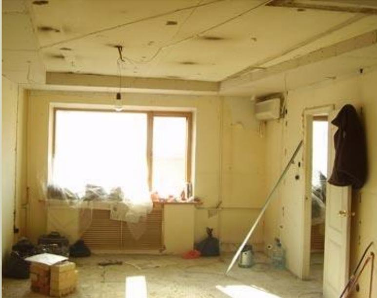
**Перед началом клейки обоев необходимо выполнить подготовительные работы: очистку стен от старого набела, старых обоев, выравнивание гипсовыми, либо клеевыми растворами, шпатлевку и шлифовку стен.**
